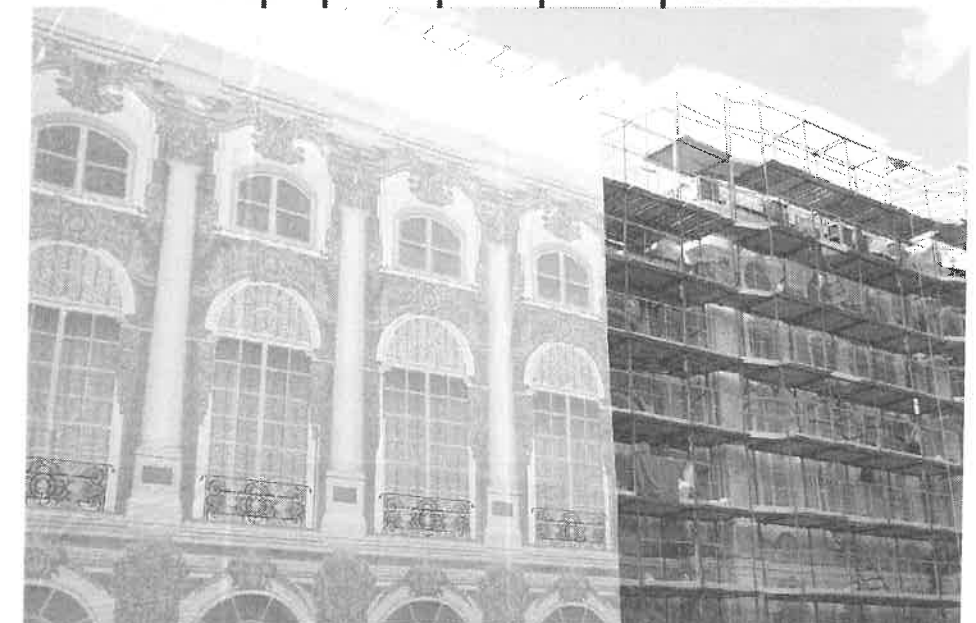
Фотография примера ограждения
